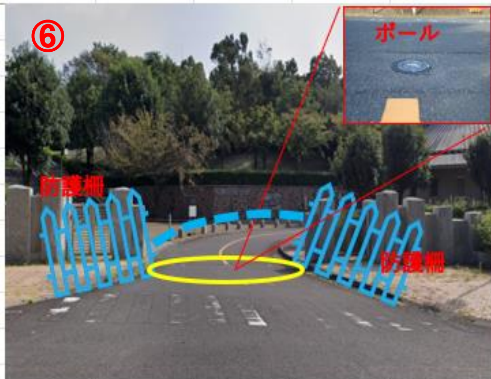
⑥公園入口の石門がある。防護柵を設置する。また路面に車止めポールが埋まっている。 ※ゴムパットで養生するが雨天は滑るためマットは撤去する。
